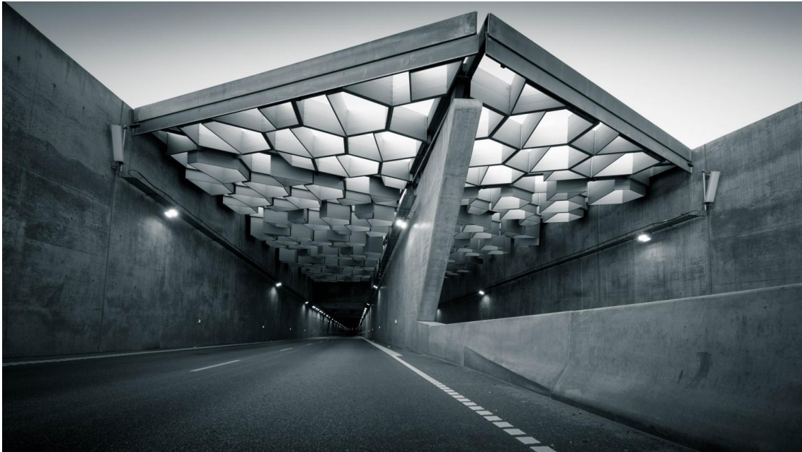
Figur 3: Nordhavnsvejstunnelen (Foto: Københavns Kommune).
