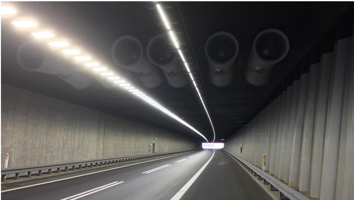
Figur 1: Foto af Silkeborgtunnelen (Foto: Vejdirektoratet)
