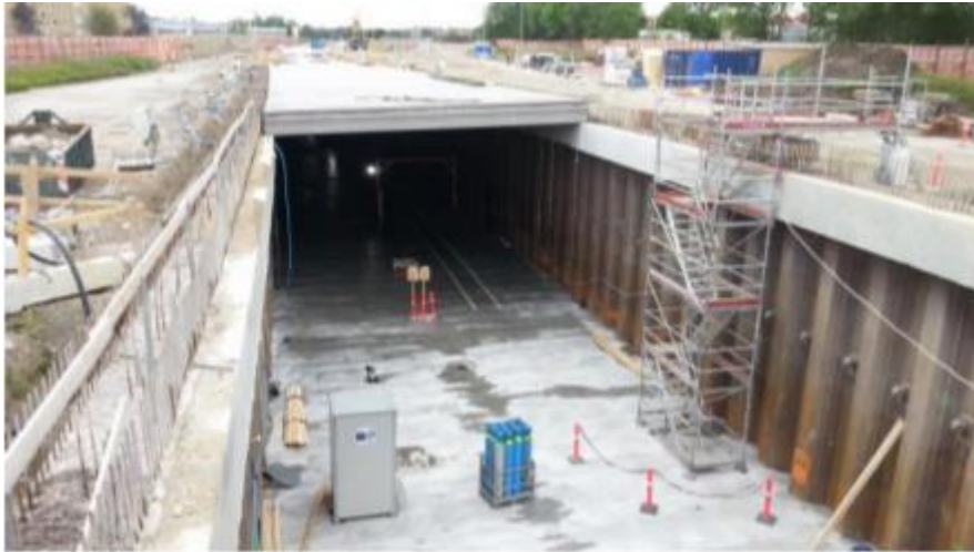
Figur 4: TP4, Kulbanetunnelen (Foto: COWI, SSO).
