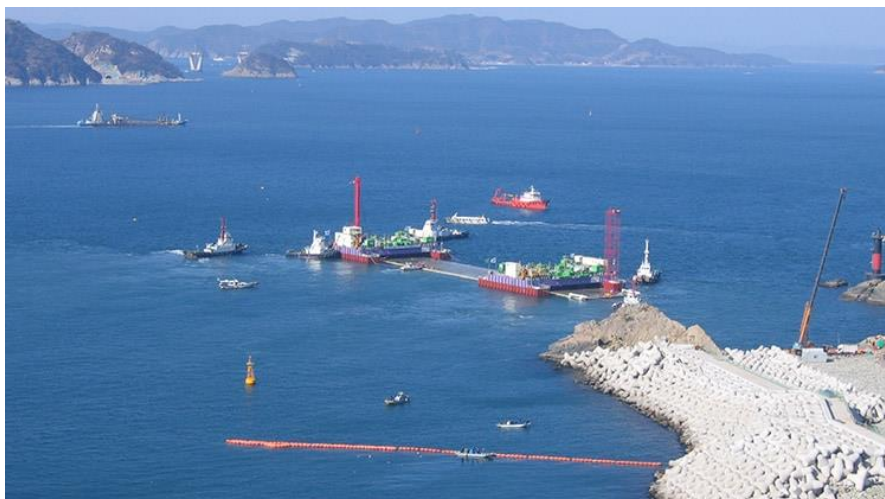
Figur 12 – Busan sænkning af tunnel element tæt på ilandføring (foto: Daewoo)
