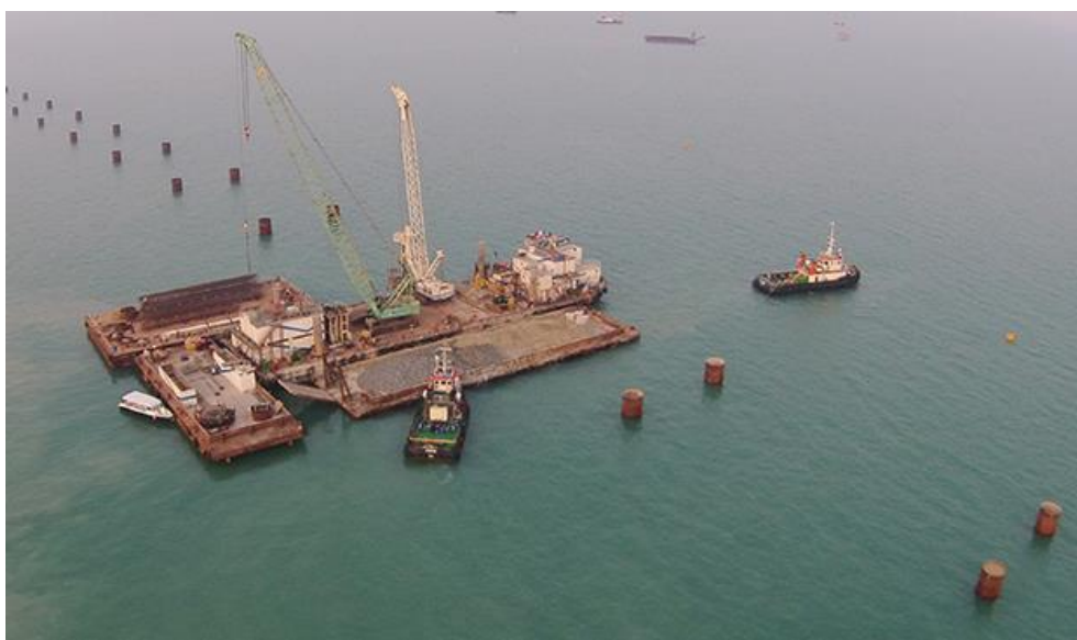
Figur 2-3 Udførelse af mono-piles fra pram (foto: [5])
