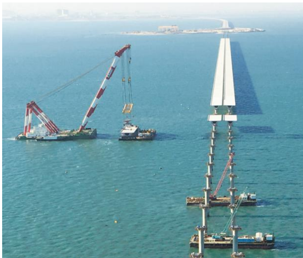
Figur 2-7 Flydekran til montering af hele fag (Main Link, foto: [3])
