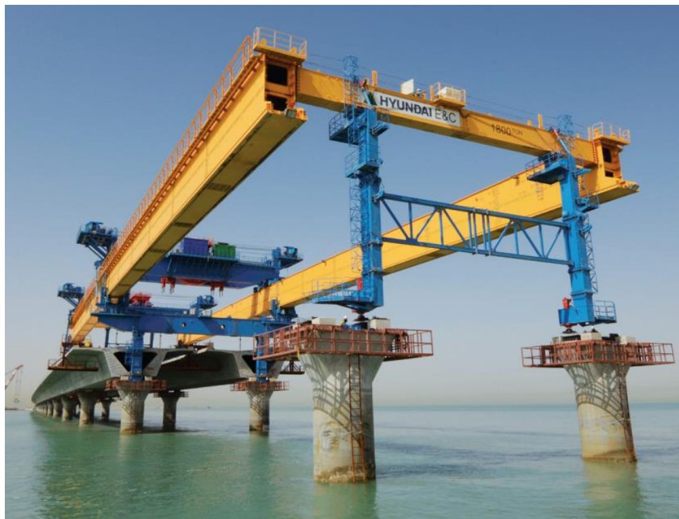
Figur 2-6 Portalkran til montering af hele fag (Main Link, foto: [3])
