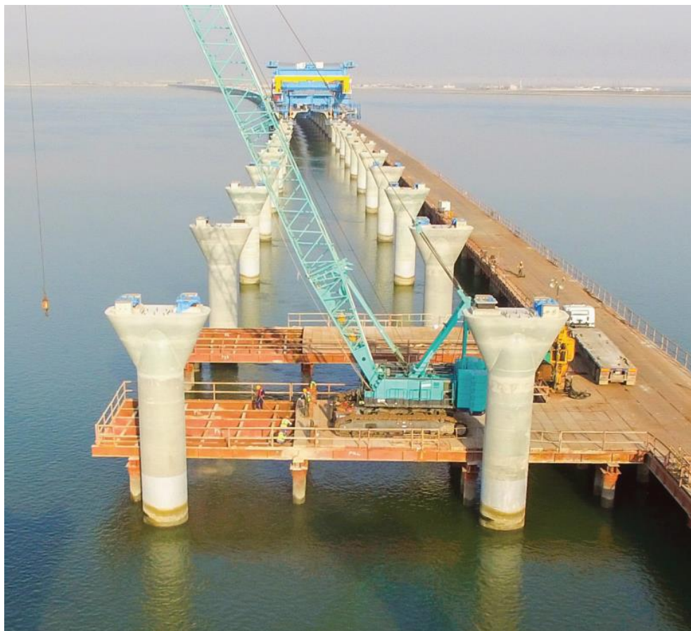
Figur 2-5 Midlertidig arbejdsbro til udførelse af del af mono-piles over vand (Doha Link, foto: [3])
