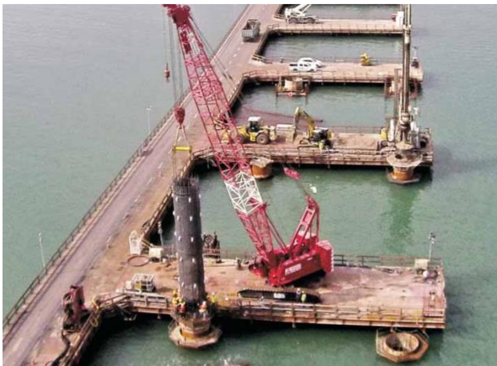
Figur 2-2 Midlertidig arbejdsbro til udførelse af mono-piles (foto: [4])
