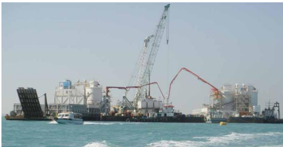
Figur 2-4 Betonblandeanlæg til udførelse af mono-piles fra pram (foto: [4])
