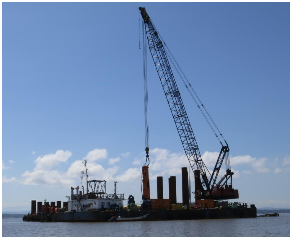
Figur 2-10 Anvendt pram til ramning af pæle (foto: Arup Hongkong)
