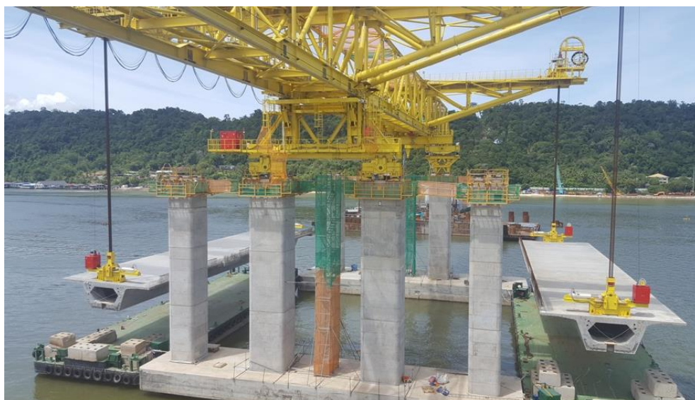
Figur 2-11 Montering af hele fag Temburong (foto: [10])
